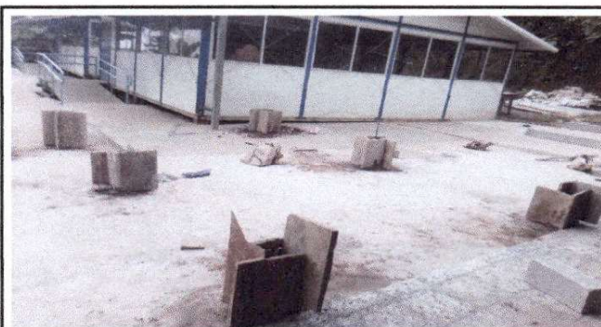
Foto 3: Mejoras y avances en la plancha de concreto como el los parales de galera con laminas troquelada.
