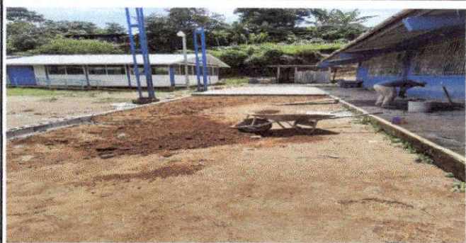
Foto1: Avance de la plancha de concreto en frente del patio.
