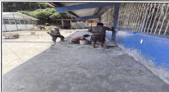
Foto 2: Avance del piso de granito por piso de torta.
