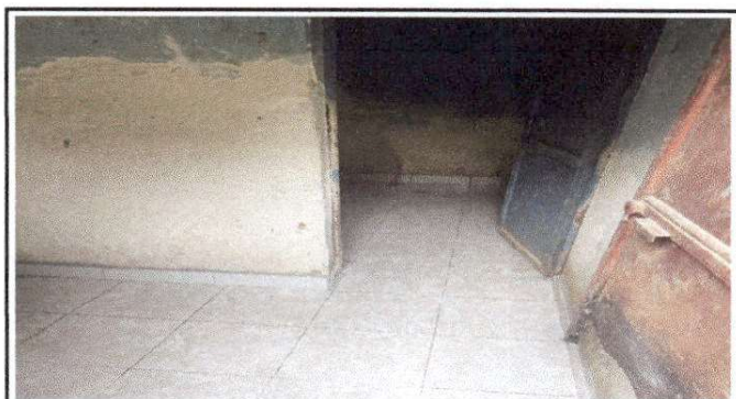
Foto 4: Avance de un 70% en la repación del sanitario.
