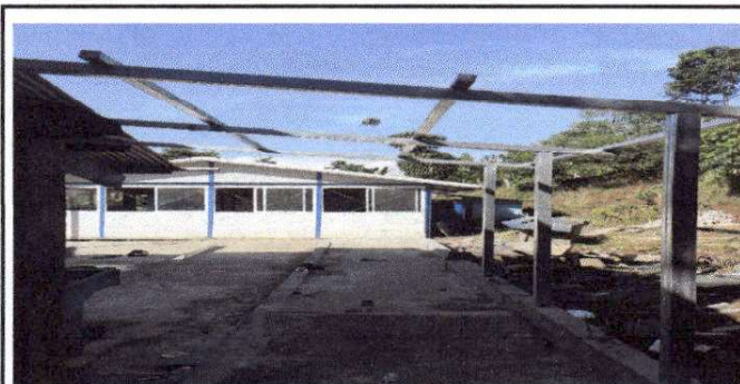
Foto 5: Mejora en la sustitución de la galera.
